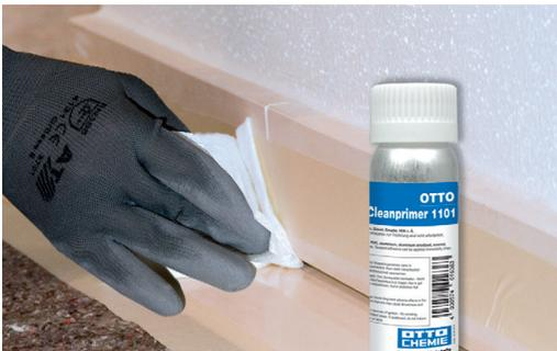
3. Application sur les flancs d'adhérence d'un apprêt approprié ou par ex. **OTTO Cleanprimer 1101 pour acrylique sanitaire**. L'application de primaire doit s'effectuer au moyen d'un chiffon propre dans le cas de supports lisses et non absorbants, ou au moyen d'un pinceau dans le cas de supports absorbants.
