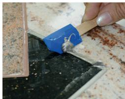
Avec l'arête adaptée, l'outil de lissage OTTO humidifié avec l'agent de lissage est inséré avec une pression homogène sur le joint garni.
