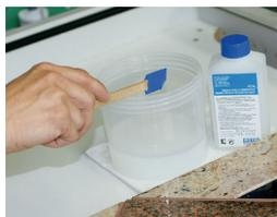
Puis l'outil de lissage OTTO est ensuite à nouveau humidifié et le joint est lissé en suivant la technique désignée. Après le lissage, les résidus d'agent de lissage restant sur les carreaux ou plaques doivent être éliminés afin d'éviter l'apparition de traces. Il en résulte un joint parfait.
